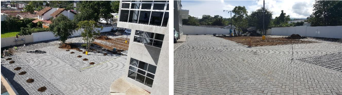
Parqueo prácticamente concluido
