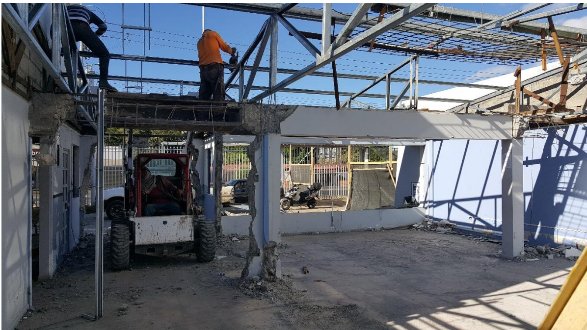
Demolición de la antigua sede
